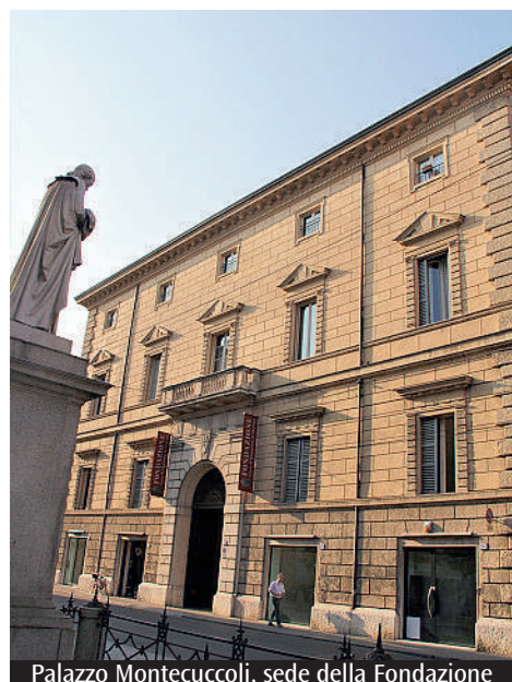
Palazzo Montecuccoli, sede della Fondazione
